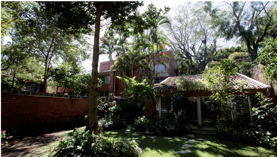
Vista principal del edificio de Rectoría, UCA, Antiguo Cuscatlán (Sistema Consultores, 1978) Fotografía de Óscar Leiva (2012), propiedad de Fundación AccesArte
